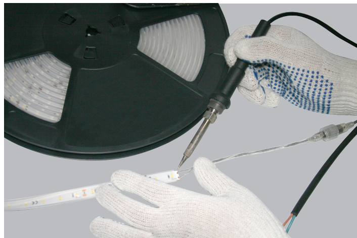
4. Припаять контакты коннектора Crystal к отрезку светодиодной ленты
