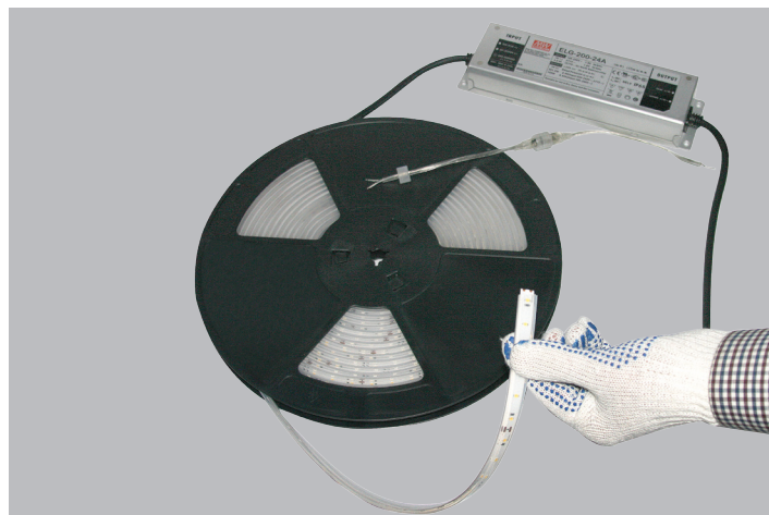
2. Зачистить силиконовую оплетку у контактных дорожек
